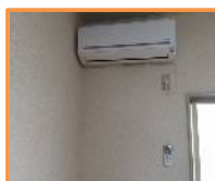
LDK エアコン新設
